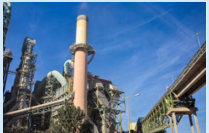
die NOx-Emissionen um mehr als 90 Prozent reduziert werden können. SCR steht für „Selective Catalytic Reduction“. Mit diesem Verfahren werden bereits entstandene Stickoxide durch eine reduktive Abscheidung nachträglich aus dem Rauchgas entfernt. Beim Einsatz dieser Technologie profitieren wir von unserer jahrzehntelangen Expertise im Bereich der Rauchgasentstickung – einem Verfahren, das von Bilfinger in mehr als 50 Kraftwerken und Müllverbrennungsanlagen eingesetzt wurde.
