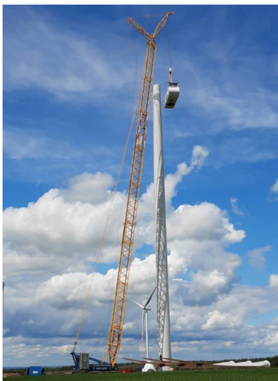
Errichtung des Windparks Górzycza von EDF
