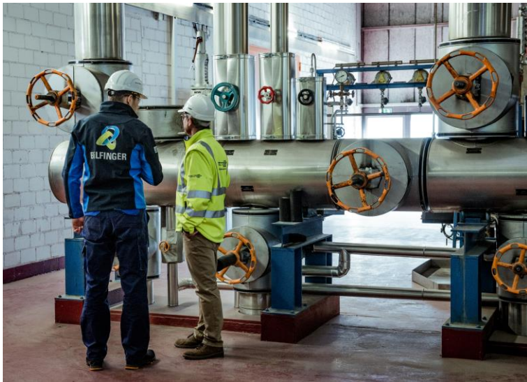
Bilfinger realisiert für die Stadtwerke Düsseldorf eine neue Energiezentrale auf dem Henkel-Werksgelände
