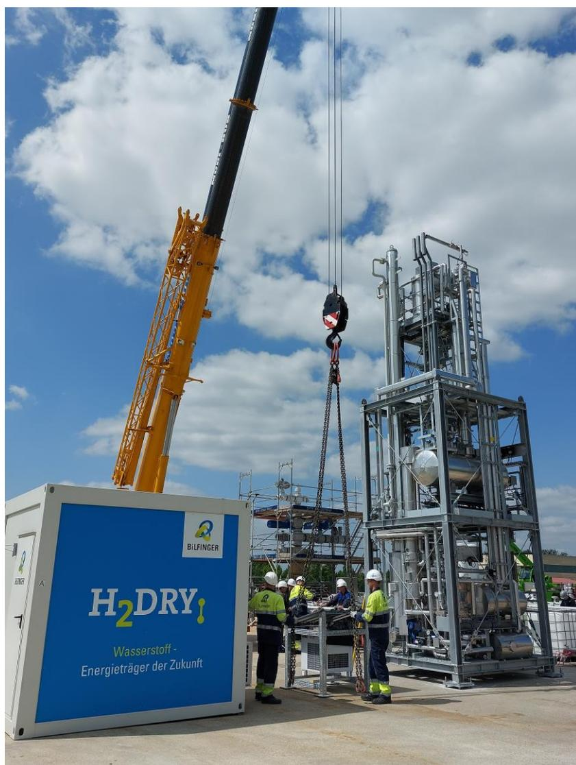
Bilfingers H2DRY-Demonstrationsanlage für die Absorptionstrocknung von Wasserstoff ist rund 9 m hoch und wiegt 9,2 t.
