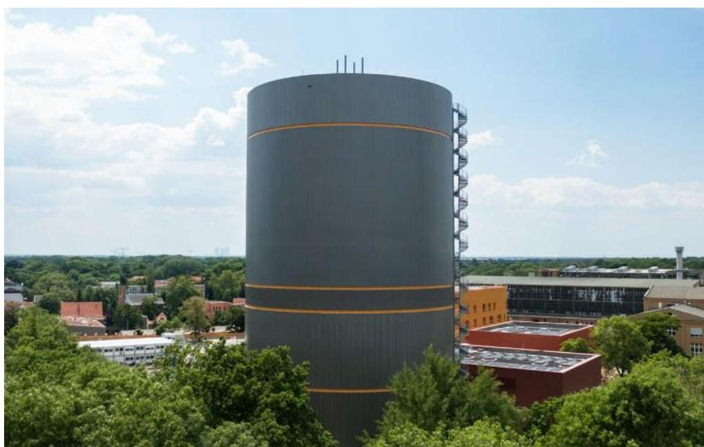
Im Wärmespeicher wird die im Kraftwerk erzeugte, aber nicht sofort benötigte, thermische Energie gespeichert und bei Bedarf in das Fernwärmenetz eingespeist.
