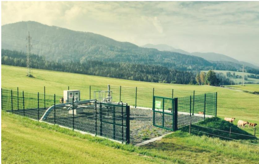
Im Zuge von HyGrid<sup>2</sup> wird der erste österreichische Erdgas-Stahlleitungsabschnitt im Netzgebiet der Energienetze Steiermark für den Wasserstofftransport umgewidmet © Energienetze Steiermark
