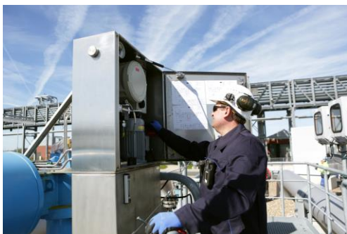
Elektroarbeiten an einer Erdgasanlage
