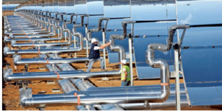
Das neue Kraftwerk Solnova in Andalusien besteht aus vier Blöcken mit einer Leistung von je 50 Megawatt, jedes Solarfeld erstreckt sich über eine Fläche so groß wie 70 Fußballplätze. Die dazugehörigen Leistungsnetze summieren sich
