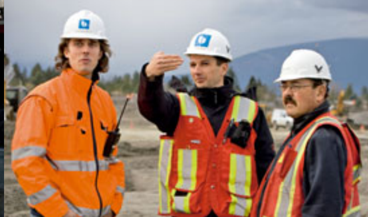
DIE ARBEITEN AN DEN ZUBRINGERN ZUR BRÜCKE AM NÖRDLICHEN UFER KOORDINIERT MARIO VIDUKA (UNTERES BILD, MITTE)
